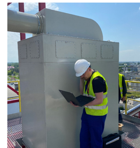
Montaż odpylni na dachu silosu przy elektrowni
