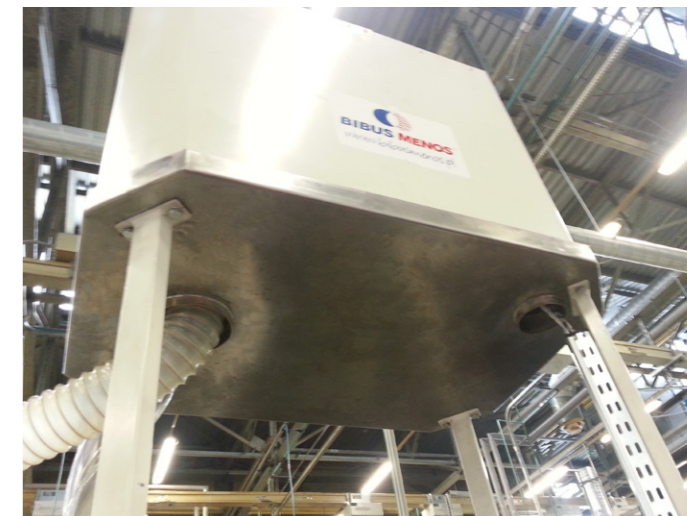
Montaż odpylni na dachu silosu przy elektrowni
