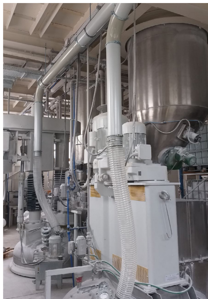
Instalacja odpylania mieszalników
